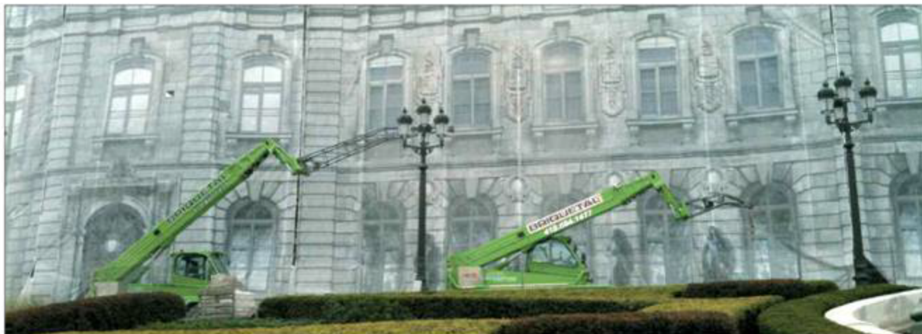
Toile recouvrant la façade de l'Assemblée nationale lors des travaux de restauration.
